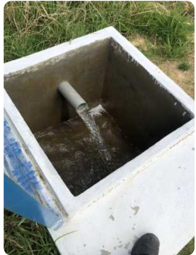
Foto 13. Tanque rompe presión en matriz de conducción
