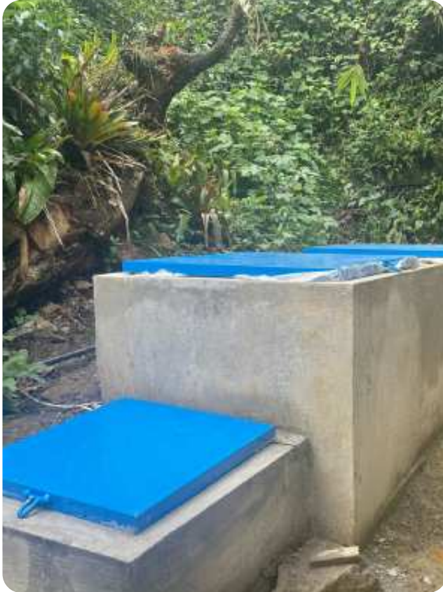
Foto 8. Desarenador del sistema de riego Pueblo Nuevo, parroquia Molleturo, cantón Cuenca, provincia de Azuay
