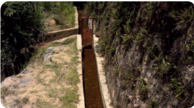
Foto 6. Sistema de derivación con compuerta en canal secundario
