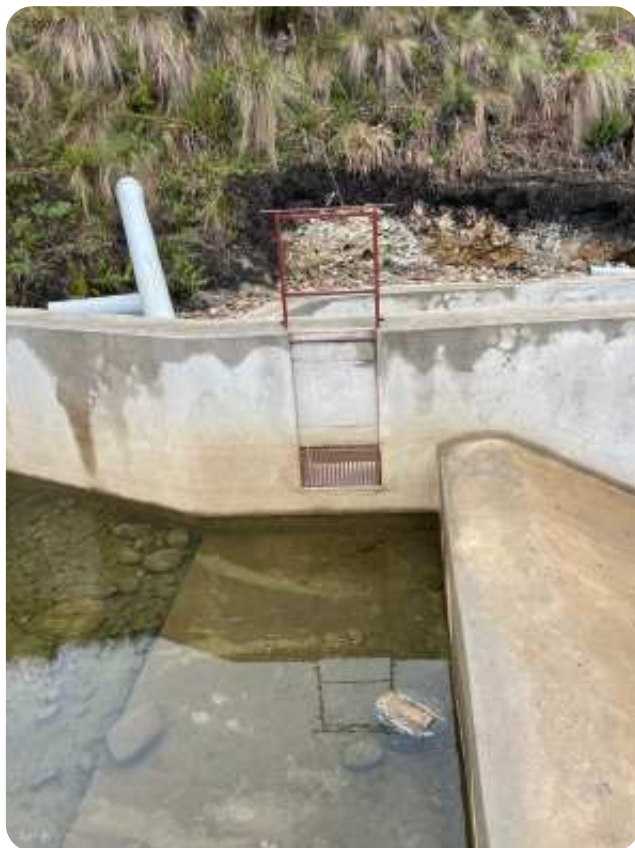
Foto 10. Rejilla en captación del sistema de riego Minas Ludo, cantón Sigsig, provincia de Azuay
