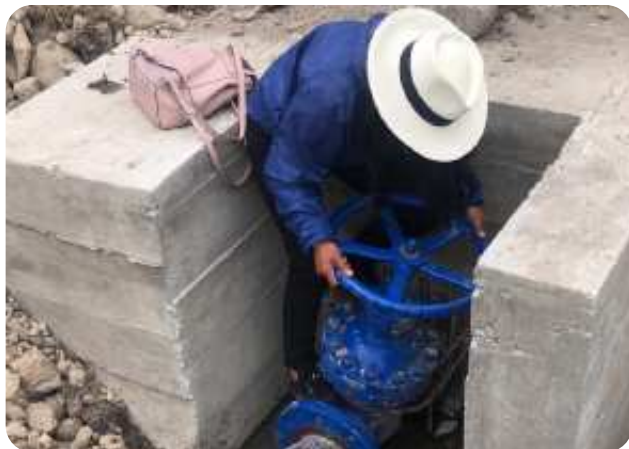
Foto 14. Prueba de una válvula de purga en matriz de conducción
