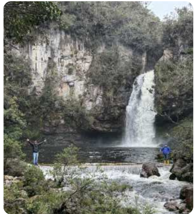
Foto 4. Dique de la captación del canal de riego Ingachaca, sistema de riego Quingoyacu Ingachaca, cantón Oña, provincia de Azuay
