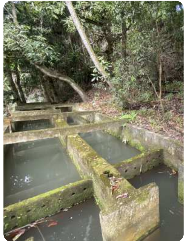
Foto 7. Desarenador del sistema de riego Llaushari 2, cantón Santa Isabel, provincia de Azuay
