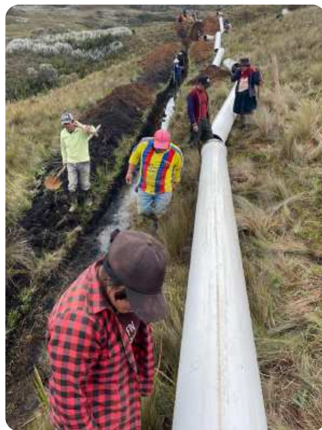
Foto 11. Instalación de tubería de la línea de conducción del sistema de riego Río Minas Ludo, cantón Sigsig, provincia de Azuay
