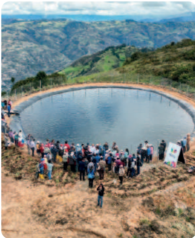
Foto 17. Reservorio de regulación del sistema de riego Cañas Bravas, parroquia Chicán, cantón Paute, provincia de Azuay
