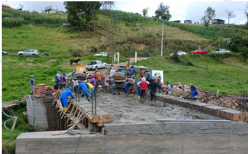
PUENTE SOBRE EL RIO ACCHAYAKU (SECTOR TUTUPALI CHICO)
