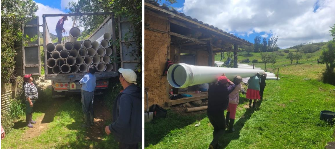
ILUSTRACIÓN 5 Y 6. ENTREGA DE TUBERÍA SISTEMA DE RIEGO CHULLA 5 DE ENERO – GUALACEO
