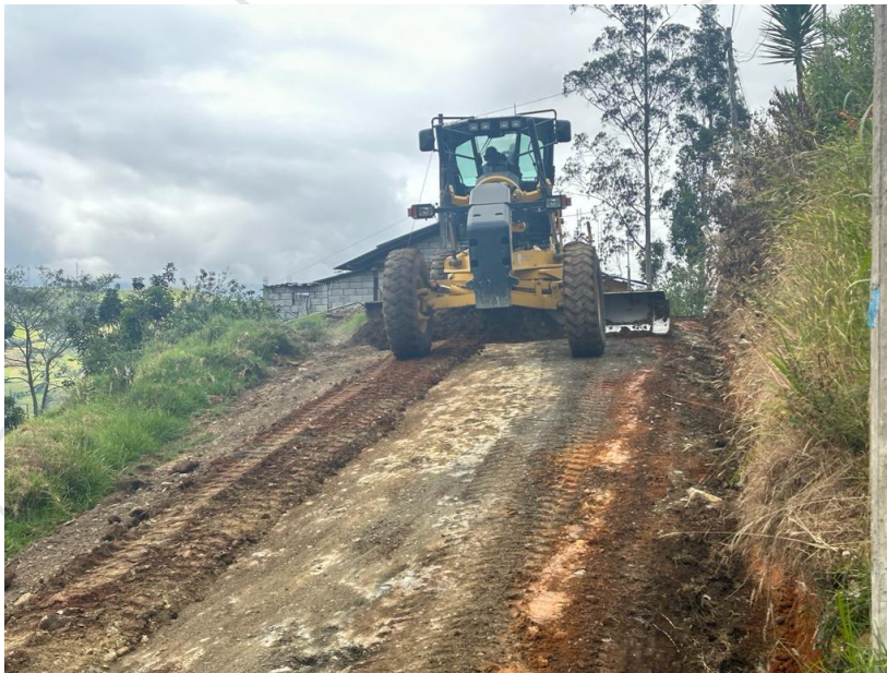
MANTENIMIENTO VAL CANTÓN EL PAN
