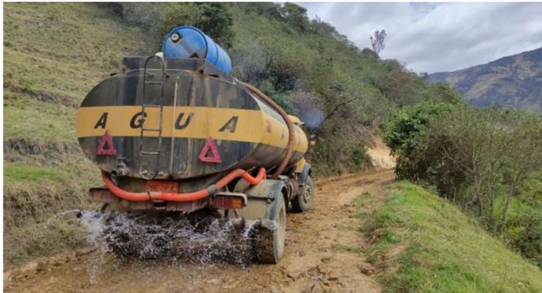
Proceso de colocación, hidratación y compactación de material de lastre para el Mantenimiento Vial Delegado 2021. Parroquia Daniel Córdova Cantón Gualaceo
