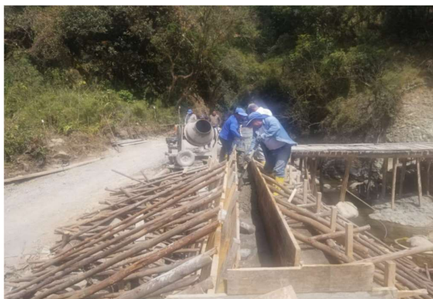
Puente en el sector de Latapamba – Cantón Pucará Luz: 11m - 05/12/2022.
