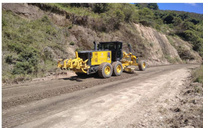
Vía Don Julo-Bajo cantón Guachapala Longitud 1,5 Km - 31/10/2022.
