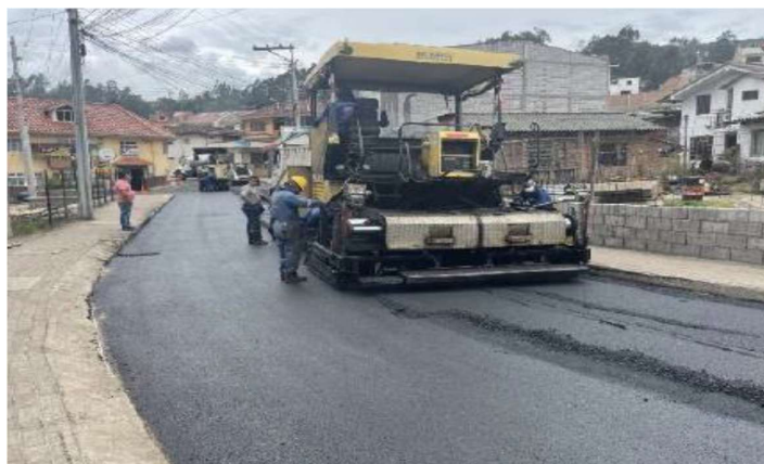
Bacheo asfáltico en diferentes calles de la Parroquia Baños Cantón Cuenca
