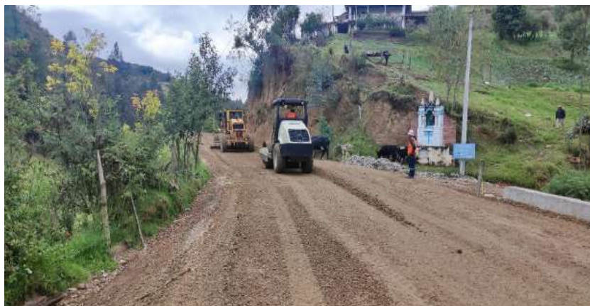
Provisión, tendido, mezclado, sellado de Sub base de la vía Quingeo - “Y” De Cumbe del cantón Cuenca
