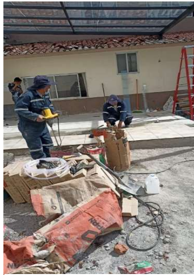
Construcción del Comedor en el edificio de la Calle Bolívar.
