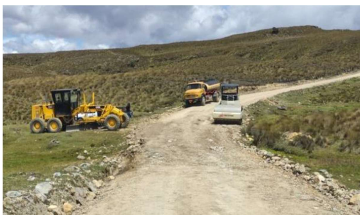
Proceso de colocación, hidratación y compactación de material de lastre para el Mantenimiento Vial Delegado 2021 Parroquia Mariano Moreno Cantón Gualaceo
