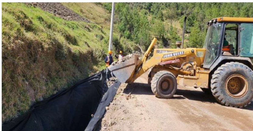
Mejoramiento a nivel de carpeta asfáltica de la vía Quingeo - “Y” De Cumbe, desde la abscisa 0+000 hasta la 7+260, del cantón Cuenca.
