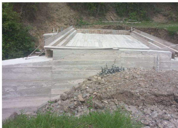
Puente en el sector de Pacay, Cantón San Fernando. Luz: 6m - 17/10/2022.
