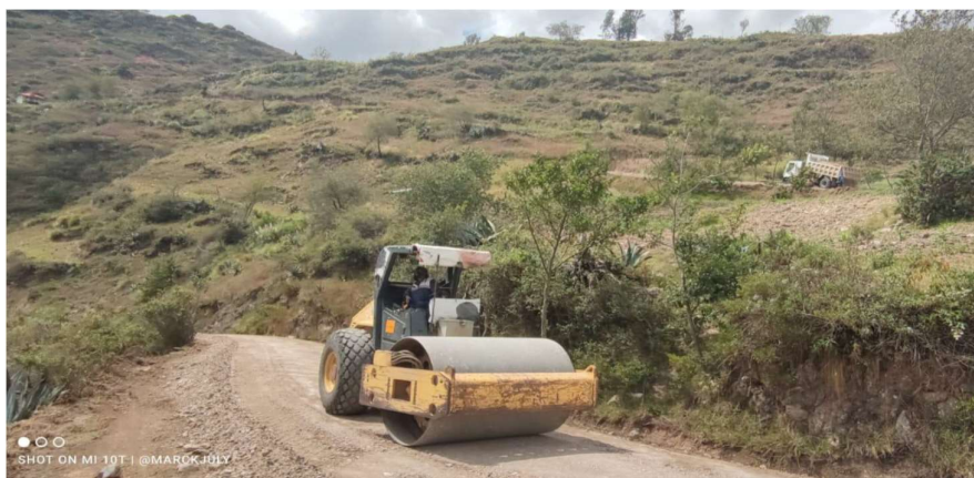
Vía San Bartolomé Delegsol – Sorche – Gondeleg – cantón Chordeleg Longitud 6 Km - 28/12/2022
